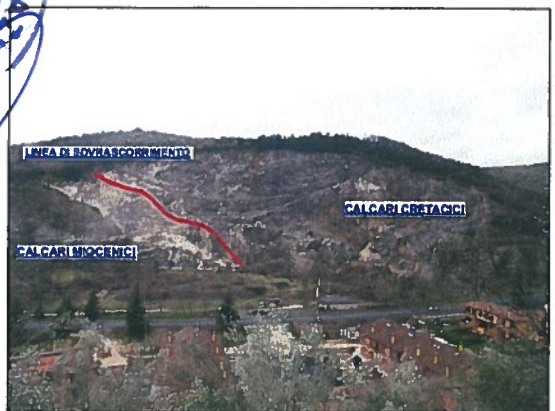
FOTO 4- TRUSS FRONTE DI CAVA VALLE CARCARA
