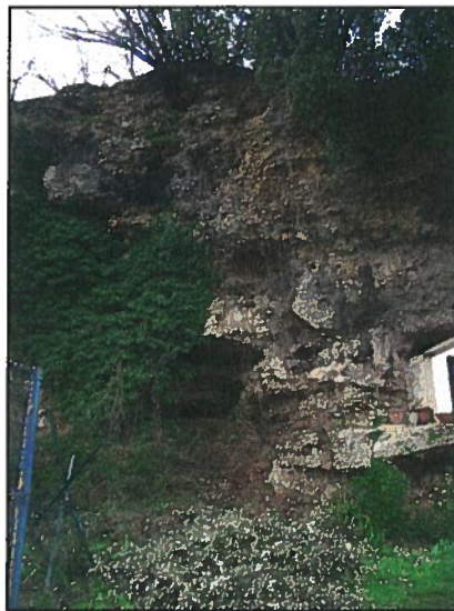
FOTO 7 – AFFIORAMENTO PONTE D'ALLOGGIO
