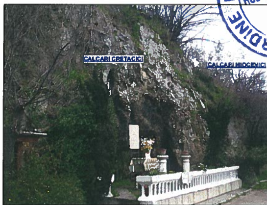
FOTO 3 - SOVRASCORRIMENTO S.S.155- Km 10+000
